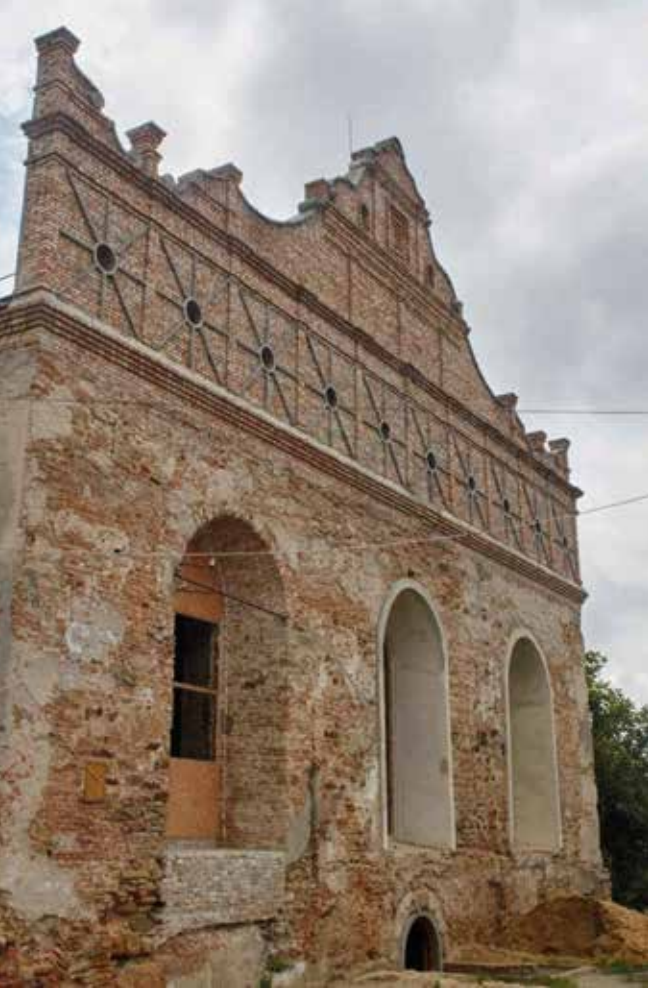
Synagoge in Ostroh im Wiederaufbau
